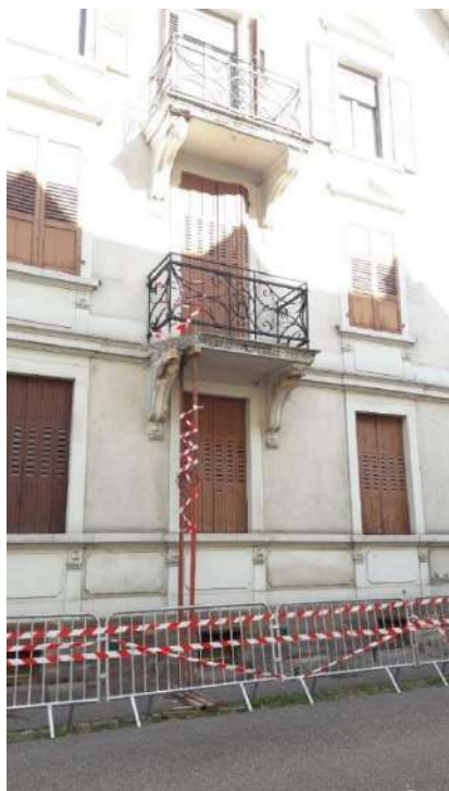
Chutes d'éléments d'un balcon, sécurisation
