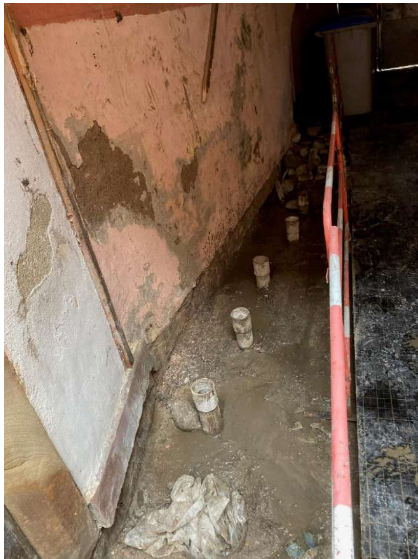
Mise en œuvre de micropieux pour reprise en sous-œuvre des fondations
