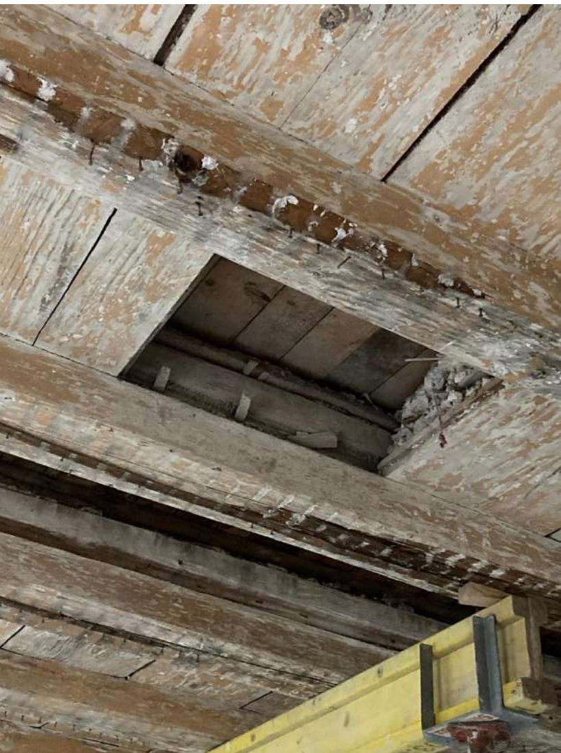
Reprise structurelle sur plancher du 17 e siècle
