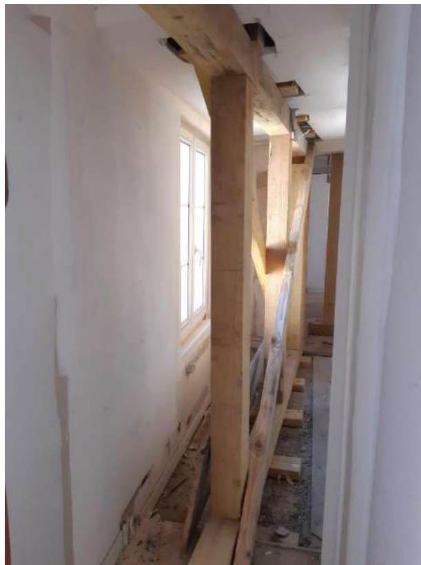
Reprises structurelles intérieures
