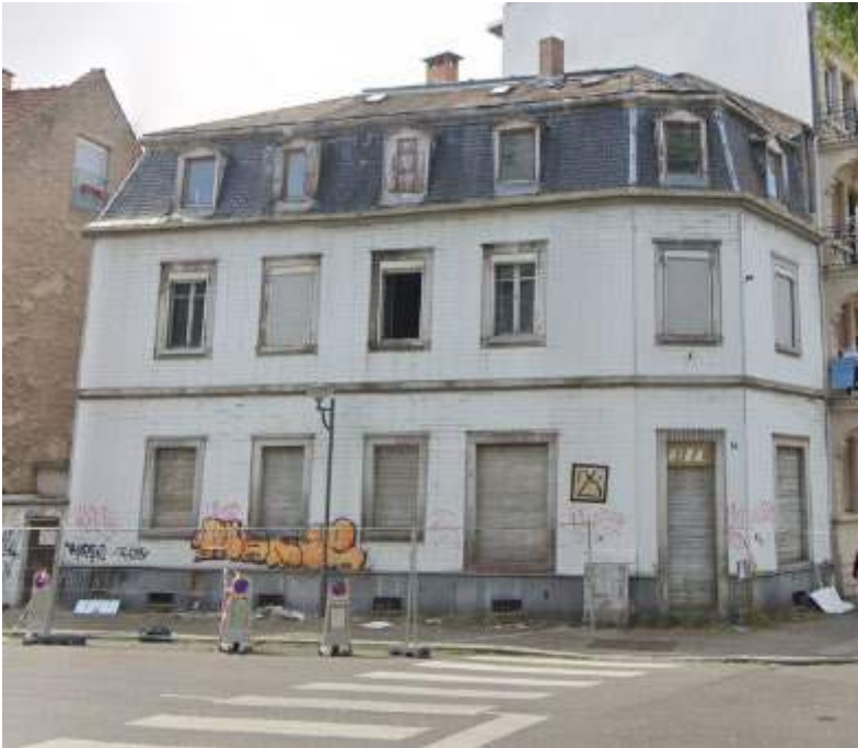
14 rue Saint Aloïse, Strasbourg – immeuble de 1900
